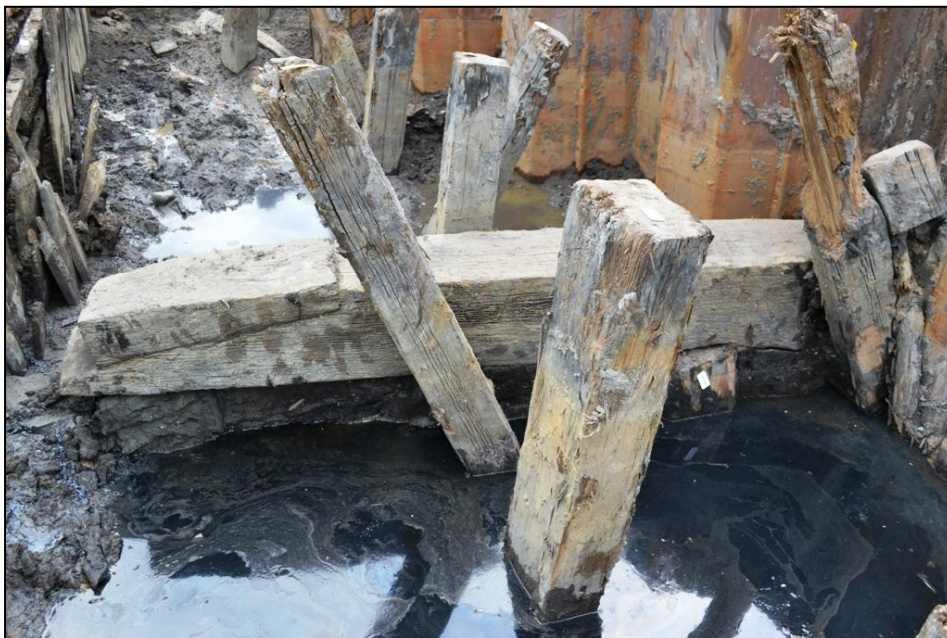
Figur 16. På et landanker fra Fase 1 i den nordlige ende af udgravningen sås resterne af en bladsamling (S10944). Denne tilskæring anvendes ved forlængelse af et stykke tømmer og forudsætter at bjælkerne er understøttede i sammenstødet. Ved afsavning af landankrene er der skåret lige igennem samlingen.
