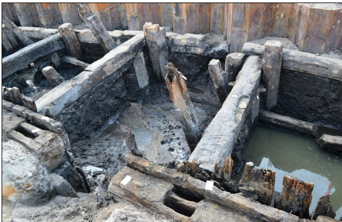
Figur 13. Blotlagt tømmer fra Fase 1. Bemærk hvordan hammerbåndet og det bagerste stræktømmer er gennembrudte af en senere nedgravet kloak.
