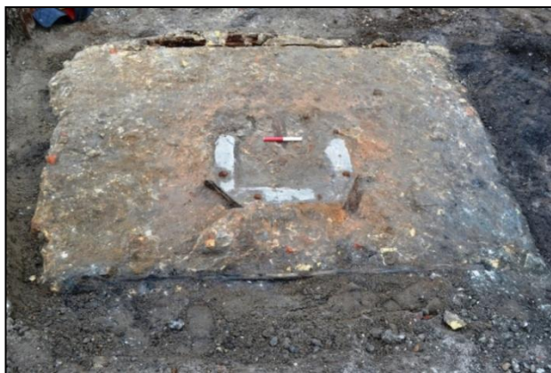
Figur 22. Punktfundament til pullert S10380.
