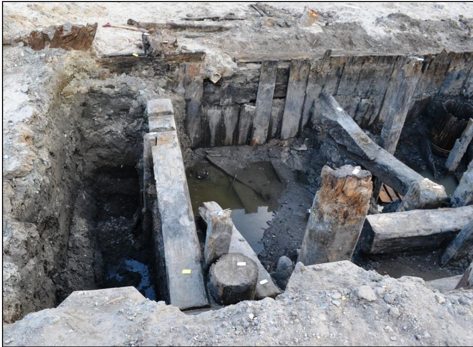
Figur 15. Centralt i billedet ses landanker S12062 (Fase 1), hvorpå landanker S10003 (Fase 2) har hvilet. Man aner udskæringen til en forsætning eller forsats. I tømmerfaget anvendes denne forbindelse når stykkerne skærer hinanden under en spids vinkel, og det ene stykke er udsat for et stort tryk. Den dobbelte forsætning anvendes, når vinklen er meget spids. I dette tilfælde kan forsætningen primære funktion ikke have været anvendt til at støtte en overligger anlagt i en spids vinkel, fordi forsætningen i så fald vender i den forkerte retning.
