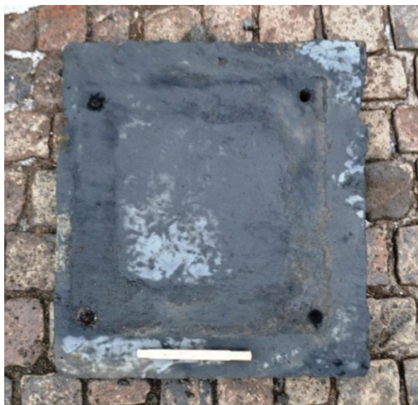
Figurer 48 & 49. Kalkstenspladerne med gennemborede huller og isiddende trænegler.
