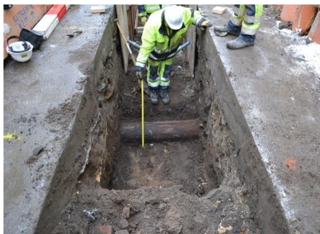
Figurer 44 & 45. Prop fra S100074 (venstre). Stikledningsvandrør S100063 på tværs af Dronningensgade 57 (højre).
