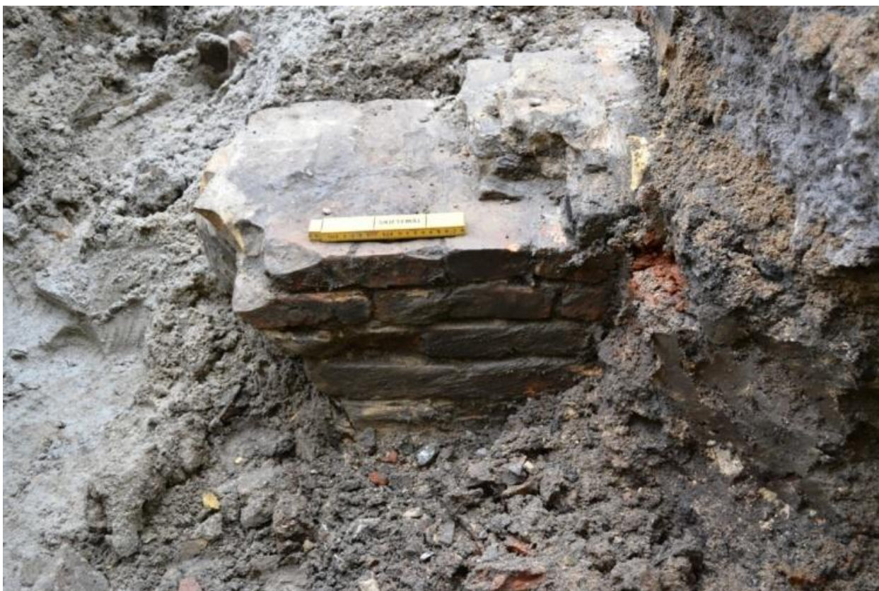
Figur 37. Teglstensfundament S100065 i Dronningensgade.
