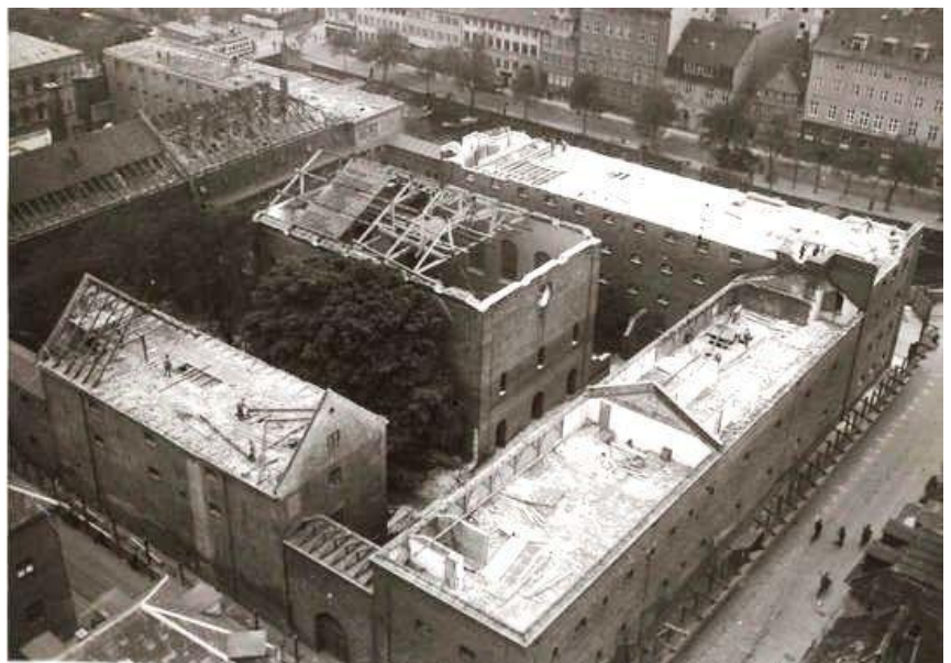
Figur 7. Straffeanstalten under nedrivningen i 1928. Fundamentet til ydermuren hørende til bygningen til højre i billedet kunne følges hele vejen i fjernvarmetraceét. Fundamentet mod Dronningensgade nederst i billedet blev også påtruffet.
