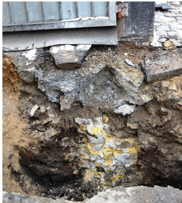
Figur 33 & 34. Teglstensfundament S100053 ved facaden mod Dronningensgade.
