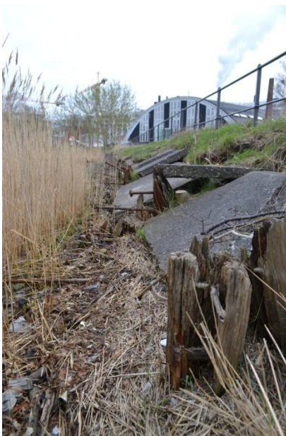
Figurer 6 & 7. Venstre: Træstolpe med skruebolt. Højre: Del af gammel bredsikring langs dæmningen.
