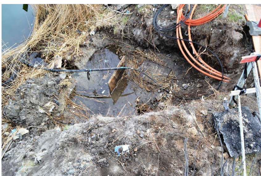
Figur 5. Hul 2: Bunden af hullet er i samme niveau som bastionsgravens vandspejl.
